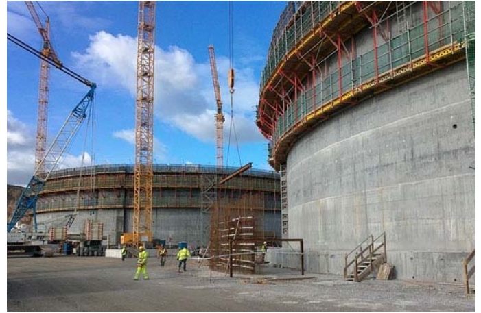
Mantenimiento e Instalación de Obra para Dique Torres
